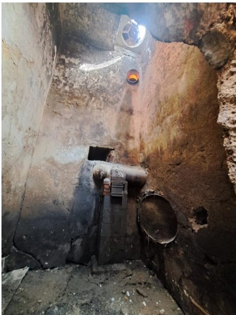
Foto 5 e 6 – grado di ammaloramento della cameretta di ispezione da demolire e ricostruire
