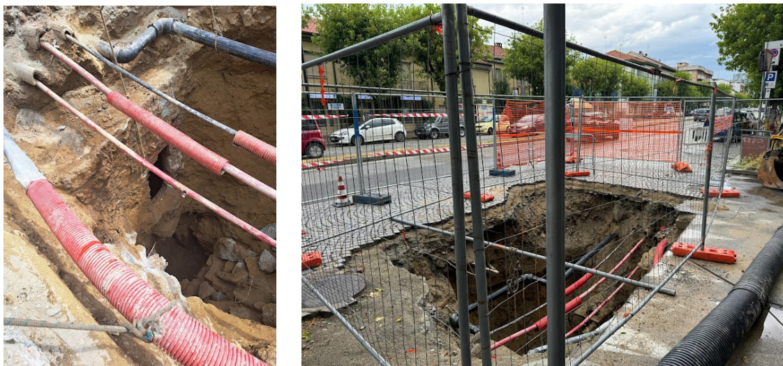
Foto 1 e 2 – secondo dissesto individuato (collegamento tra pozzetto e Rio Crosio intubato)
