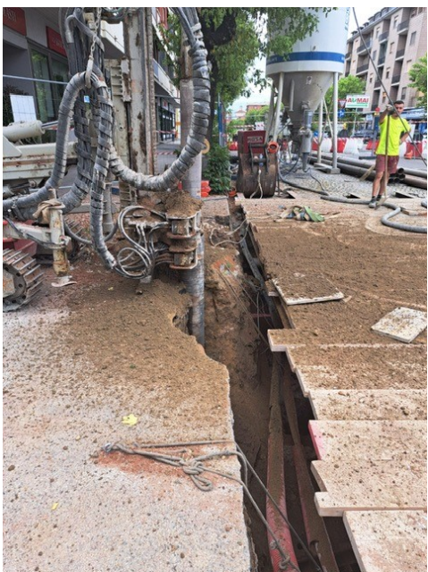
Foto 7 e 8 – realizzazione della paratia di micropali a sostegno delle pareti di scavo
