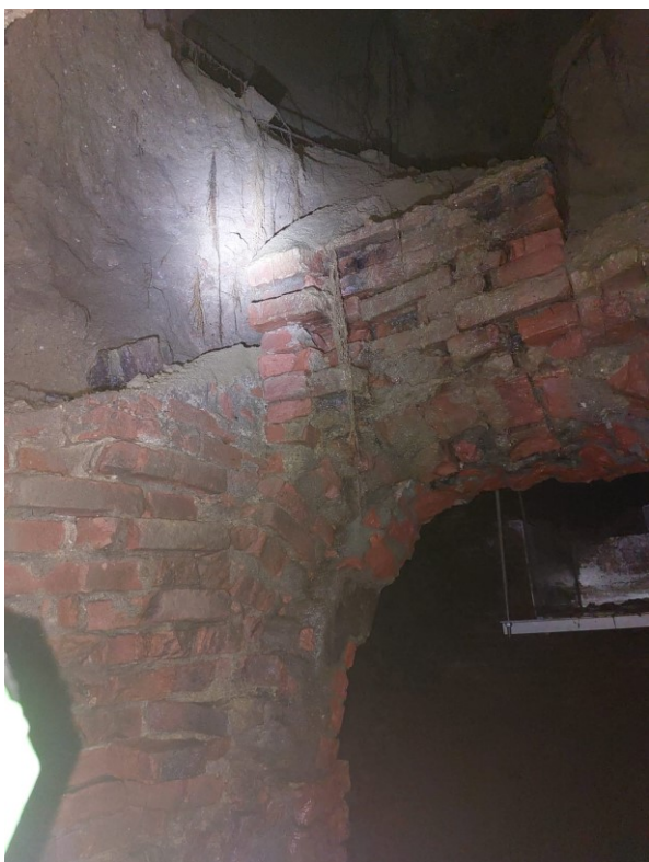
Foto 1 e 2: parziale collasso e cedimento in corrispondenza del nodo fognario di Via Buozzi / Corso Torino (31/5/2024)
