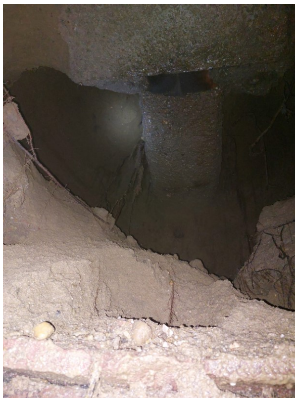
Foto 1 e 2: parziale collasso e cedimento in corrispondenza del nodo fognario di Via Buozzi / Corso Torino (31/5/2024)
