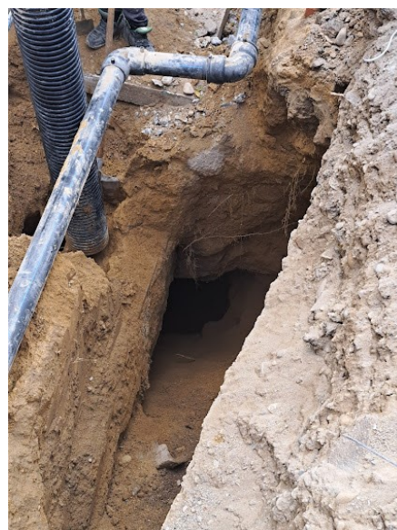
Foto 4, 5 e 6 – dissesto individuato in corrispondenza della prima corsia di marcia di Corso Torino in uscita dalla città
