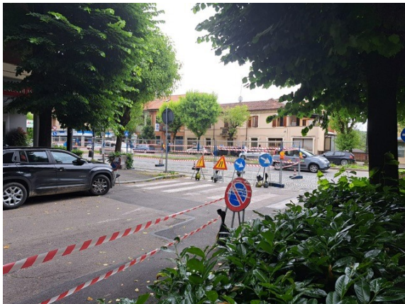
Foto 3 e 4 – cantierizzazione con restringimento di carreggiata su Corso Torino
