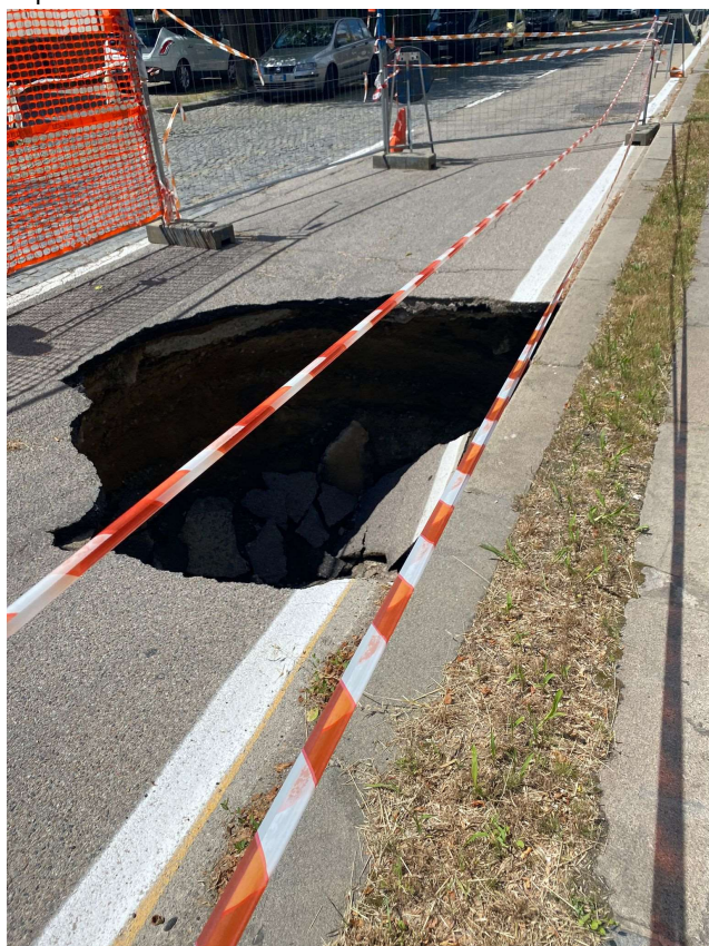
Foto 1 e 2: collasso e cedimento del manto stradale in corrispondenza della camera di ispezione in Corso Torino n. 98 (6/5/2026)
