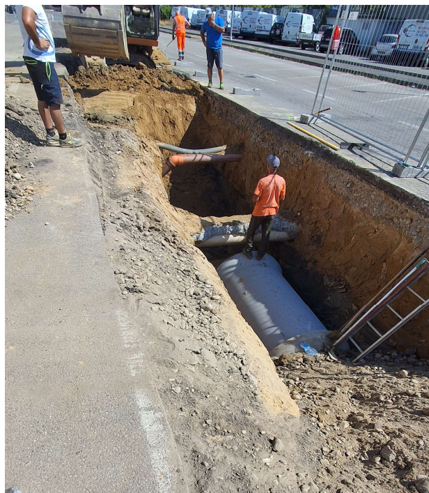
Foto 7 e 8 – operazioni di scavo con berlinese di micropali e posa della nuova condotta fognaria.
