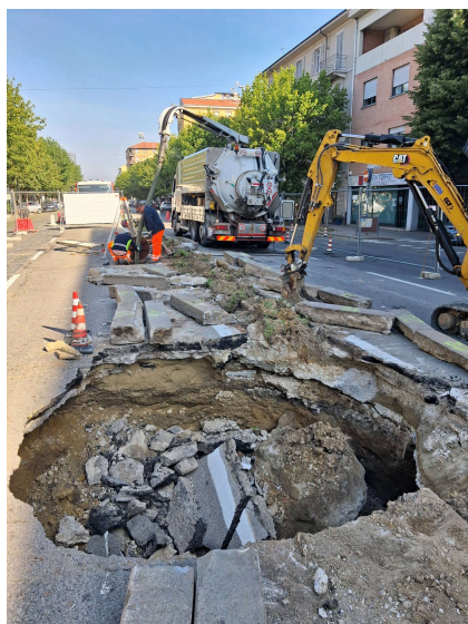
Foto 5 e 6 – dissesto individuato in corrispondenza della corsia asfaltata della carreggiata di Corso Torino in ingresso in città, con interessamento anche della corsia asfaltata della carreggiata opposta e posizionamento macchina per infissione dei micropali.
