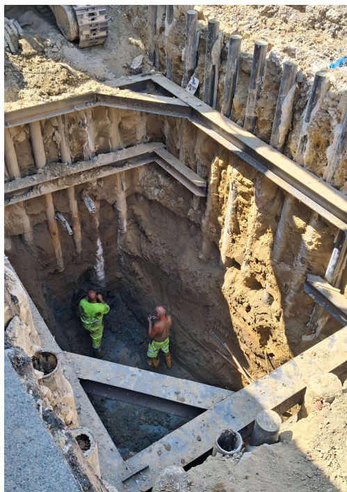
Foto 7 e 8 – operazioni di scavo con berlinese di micropali e posa della nuova condotta fognaria.
